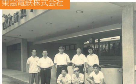
高架化以前の 新丸子駅改修工事 (1957年)
