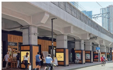
新丸子駅～武蔵小杉駅間 「高架下テナント」工事 (2019年)
