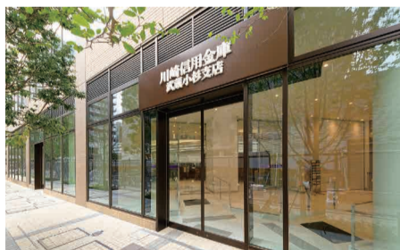
武蔵小杉支店新店舗の 施工 (2020年)
