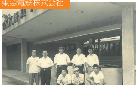
高架化以前の 新丸子駅改修工事 (1957年)
