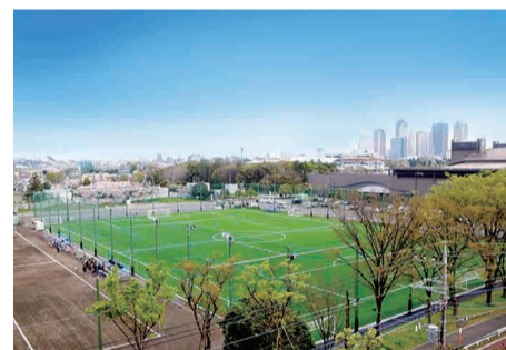
等々力第1サッカー場 人工芝化工事 (2017年)
