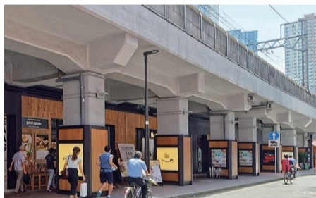
新丸子駅～武蔵小杉駅間 「高架下テナント」工事 (2019年)
