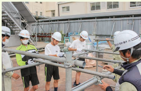
単管パイプをクランプという金具でつなぎ、ラチェットレンチで締める作業を体験！
