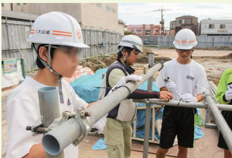
単管パイプをクランプという金具でつなぎ、ラチェットレンチで締める作業を体験！
