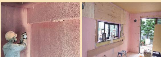
発泡ウレタン吹付工事とは、ウレタン原液を機械を用いて混合・発泡させ壁や天井に吹き付ける工法。微細な気泡構造のフォームで形成される他の断熱材よりも優れた断熱性能を持っています。
