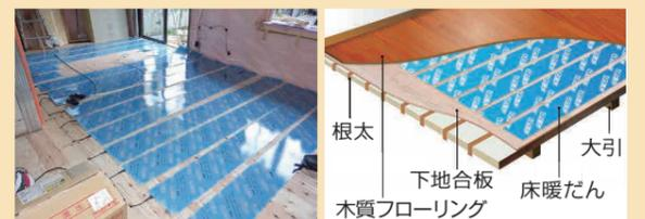
電気式の床暖房は、床下に電熱線を組み込んだパネルを設置する方式。工事がシンプルなため既存の住宅にも導入しやすく、導入費用も温水式と比べるとややリーズナブルとなります。
