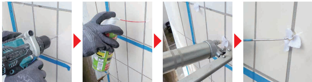
a) 躯体までドリルで穴を開ける(削孔) b) エア噴射式ノズルで穴の中の清掃(充填剤の密着強度が落ちないよう) c) エポキシ樹脂の注入 d) ステンレスピンを入れ、樹脂モルタルで穴を塞ぐ
