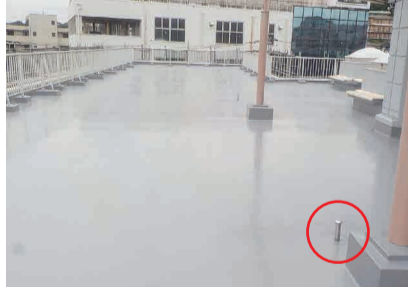
a) 既存シーラー撤去 b) シーラー接着効果を高めるプライマーを塗布。 c) 新シーラー塗布と仕上げ
