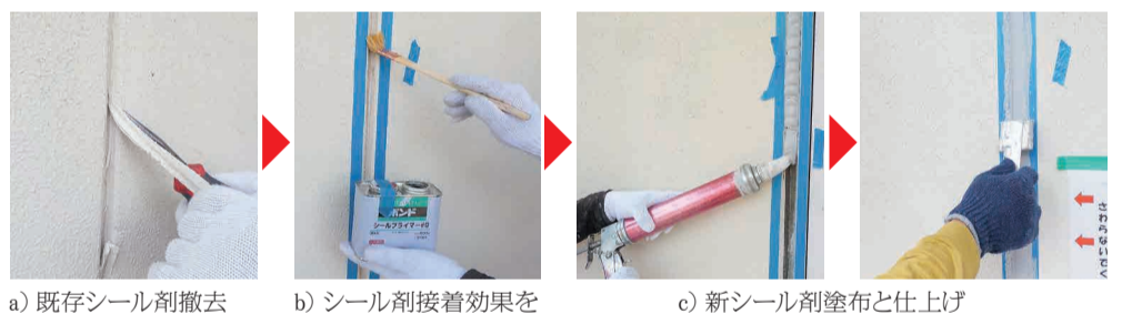
a) 既存シーラー撤去 b) シーラー接着効果を高めるプライマーを塗布。 c) 新シーラー塗布と仕上げ
