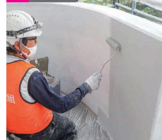
a) 既存シーラー撤去 b) シーラー接着効果を高めるプライマーを塗布。 c) 新シーラー塗布と仕上げ
