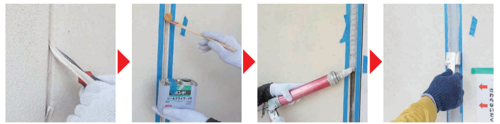
a) 既存シーラー撤去 b) シーラー接着効果を高めるプライマーを塗布。 c) 新シーラー塗布と仕上げ
