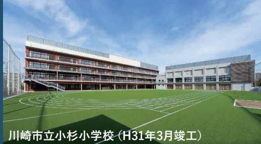
川崎市立小杉小学校（H31年3月竣工）
