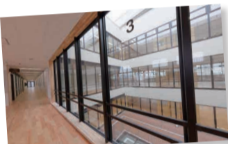
全フロア到中庭からの 採光がある校舎棟
