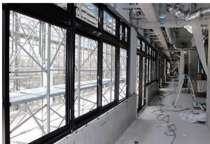
サッシ工事 (校舎棟)
