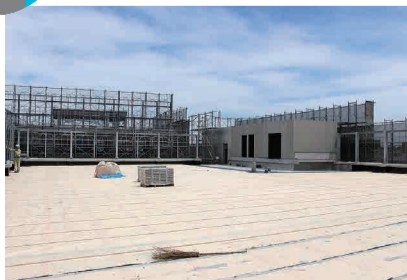
屋上防水工事 (体育館棟)
