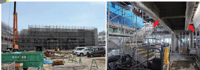
屋上躯体工事中の体育館棟
