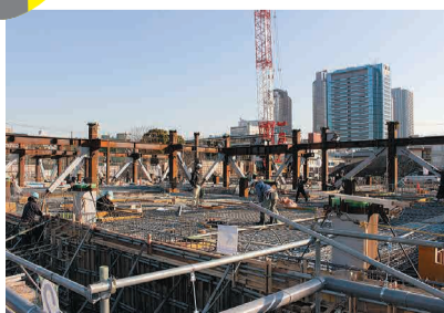
校舎棟鉄筋工事
