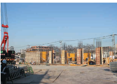
体育館棟型枠工事
