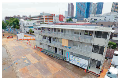
3階建て現場事務所
