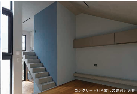
コンクリート打ち放しの階段と天井
