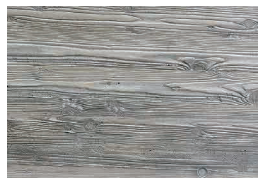
杉板のコンクリート打ち放し
