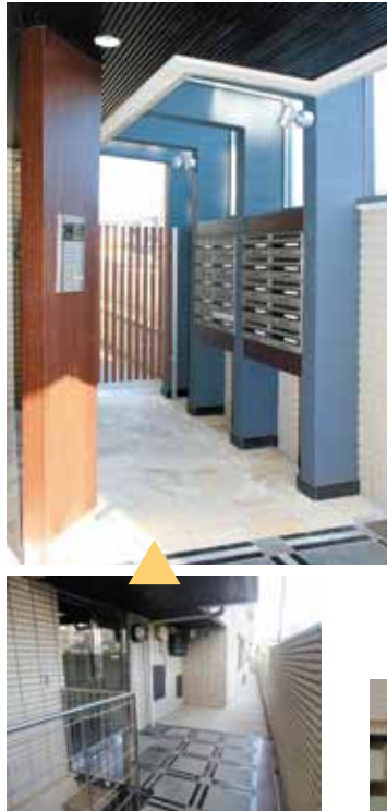
これまでエントランス内部にあった郵便受けを外部に移設(再利用し、オートロック錠を設置)
