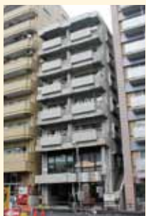
山手通り沿いの ▼ マンション
