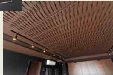
天井・壁仕上げには音響効果をあげる防音建材を使用。
