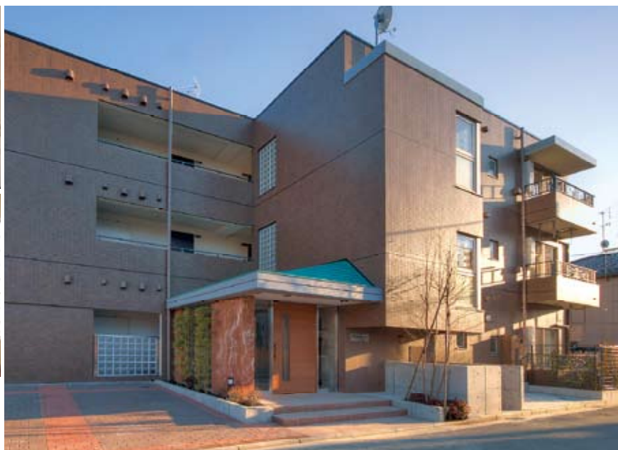
マンション全景
