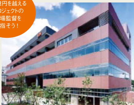
施工例/東京応化工業(株)本社ビル
