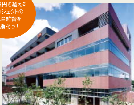
施工例/東京応化工業(株)本社ビル
