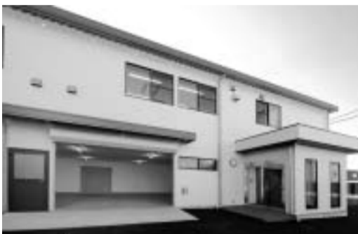
前面には搬出入用の大型シャッター
