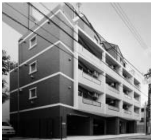
マンション外観。目の前は長原商店街
