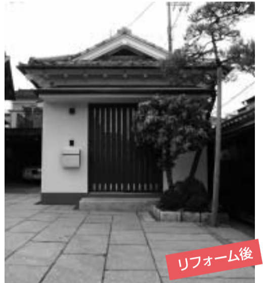
出入り口の木製引戸を霽囲気を合わせた縦格子サッシに取替え
