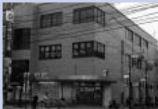
平成19年、大倉山支店改修
